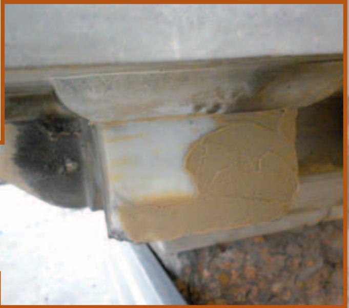
pulitura ad impacco con argille assorbenti
