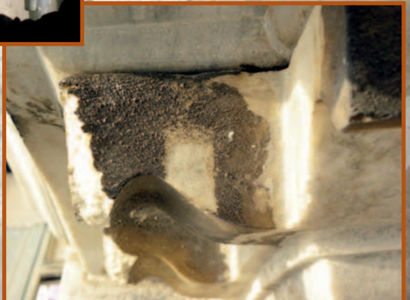
saggio di pulitura con Laser
