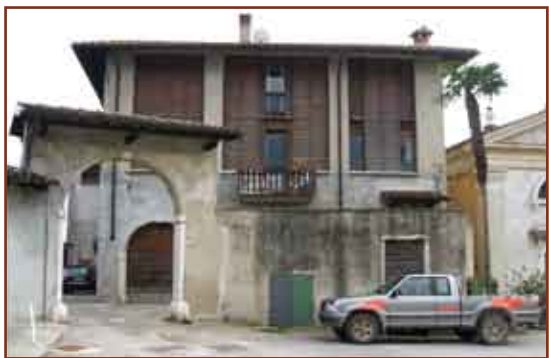
Al primo piano di questo edificio furono posti dal 1943 al 1945: l'Ufficio Comando, l'infermeria e la camerata mentre al piano rialzato la mensa del Battaglione di Polizia.
