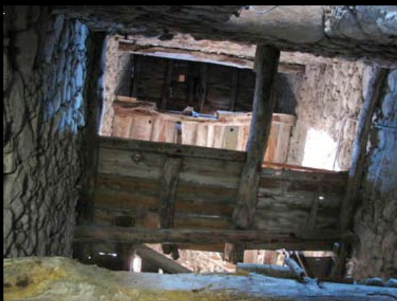
I vecchi solai visti dal basso durante le demolizioni.
