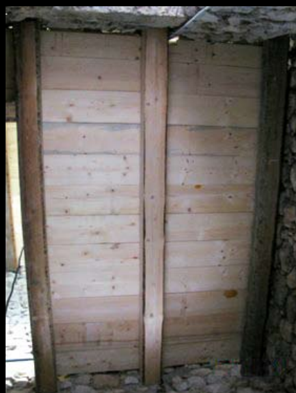
Vista da sotto di uno dei nuovi impalcati.
