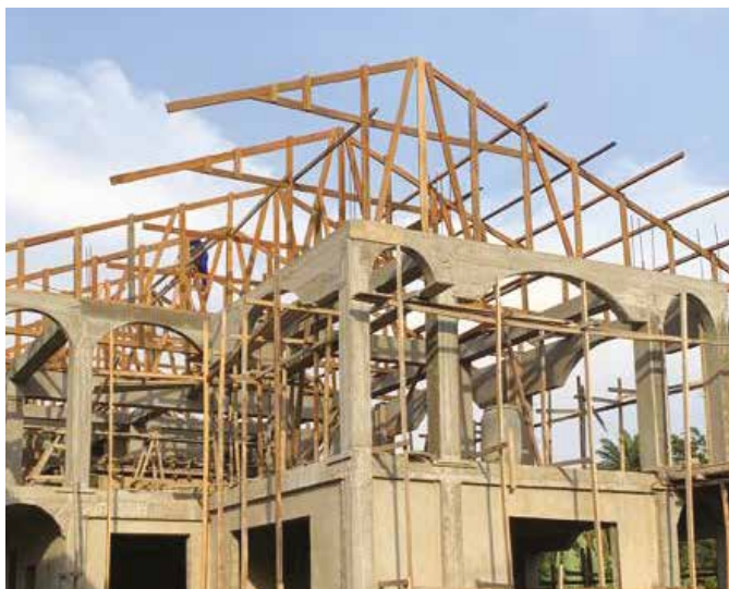
Nuova ala del Seminario in costruzione
